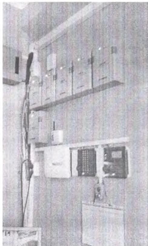
2. Система пожарной сигнализации, вневедомственной охраны
